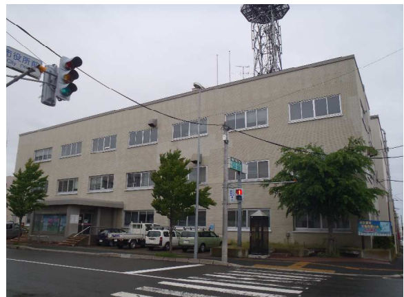
市役所西庁舎
